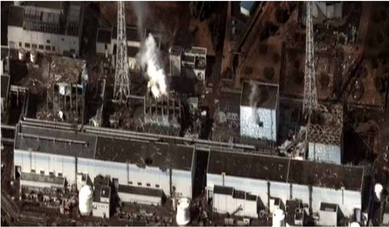
Questa foto aerea del 16 marzo mostra come gli edifici 1,3 e 4 dei reattori siano gravemente danneggiati (NYTimes)
