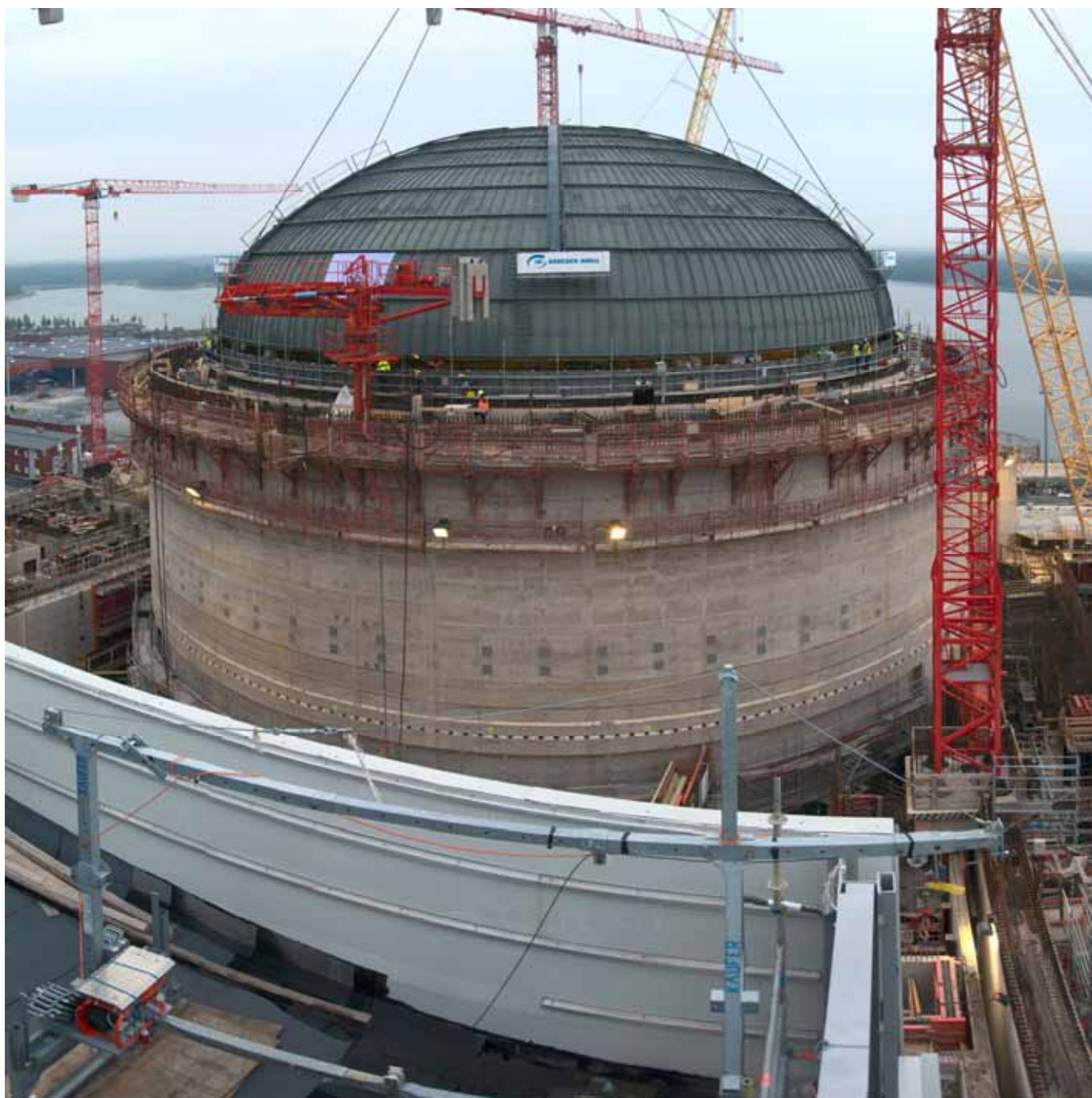
La prima centrale di tipo EPR, in costruzione in Finlandia (6 settembre 2009 – foto TVO)
