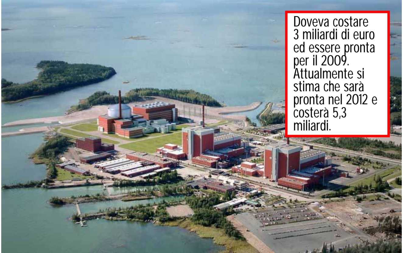
La centrale nucleare finlandese di Olkiluoto. Sulla destra i due reattori già operativi, sulla sinistra il prossimo reattore ad acqua pressurizzata EPR (in computer grafica) (Fonte Wikipedia).
