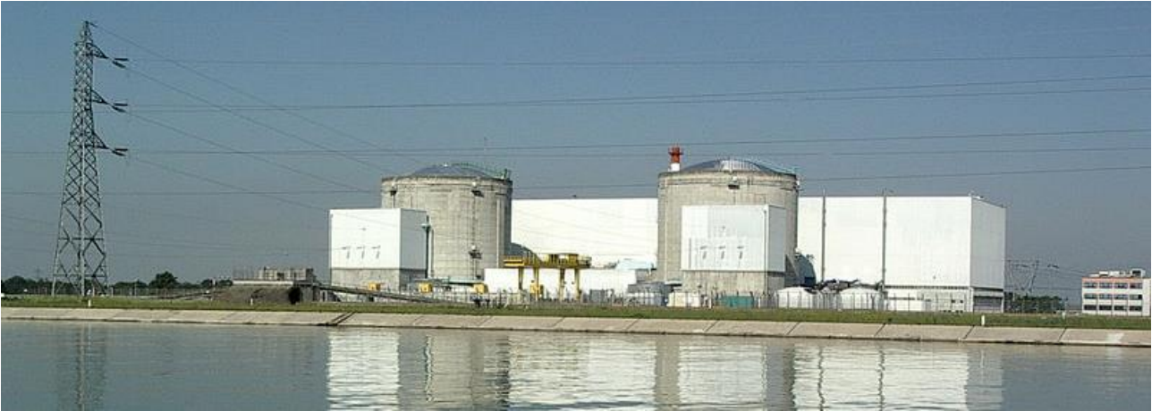
La centrale di Fessenheim 5
